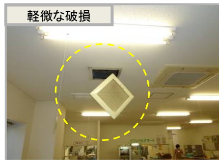
空調吹出口カバーの破損による脱落
