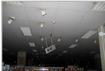
天井設備機器の破損【本館2階】
