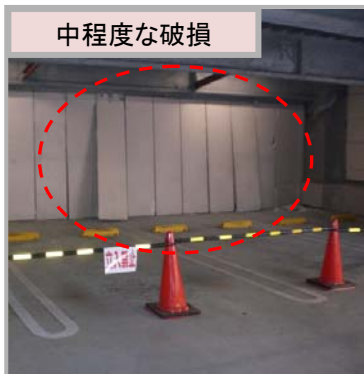
駐車場棟外壁の室内側へのズレ
