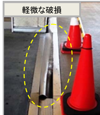
建物間のジョイント部カバーの破損
