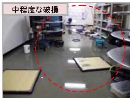
映写室にてスプリンクラー発泡による 機器類の破損
