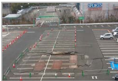
排水設備の陥没【本館前駐車場】
