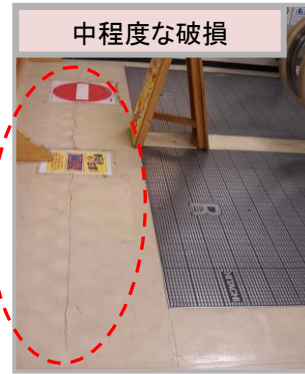
エスカレーター乗降場の床破損
