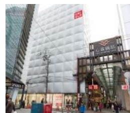
Gビル心斎橋03 ユニクロ
