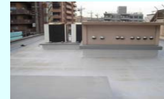
西野ビル (屋上防水補修工事)
