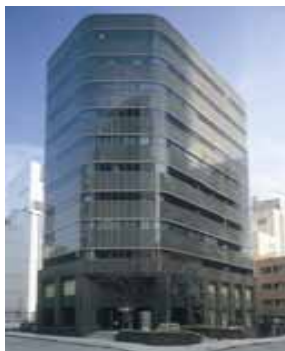
MID Imabashi Bldg. (Osaka)
