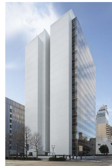
仙台キャピタルタワー
