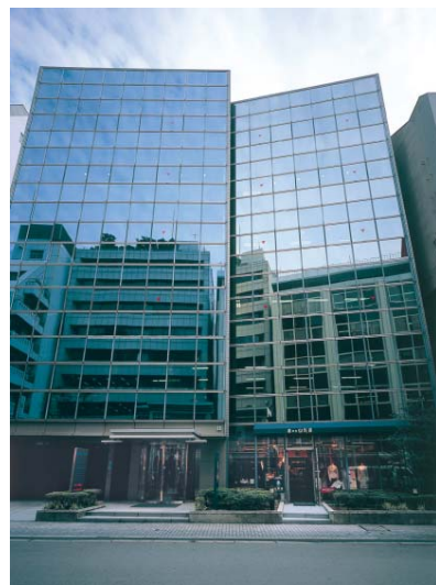
MID御堂筋瓦町ビル <大阪市中央区>
