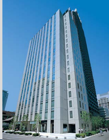
Kitahama MID Bldg.
