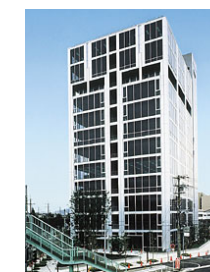
和歌山MIDビル [和歌山市] ●
