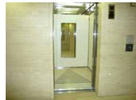
エレベータ内装リニューアル
