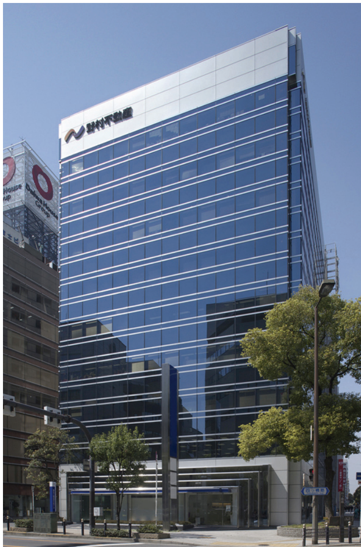
野村不動産西本町ビル外観写真
