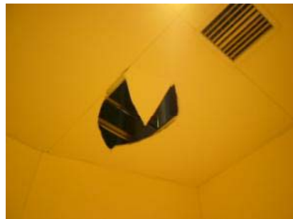
天井部材(補修前)
