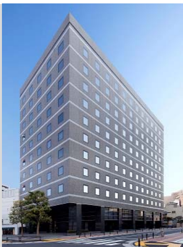
住友不動産上野ビル6号館
