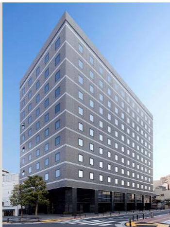
住友不動産上野ビル6号館
