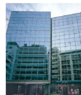
MID御堂筋瓦町ビル (大阪市中央区)
