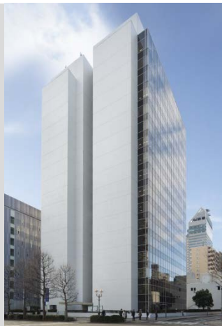
仙台キャピタルタワー
