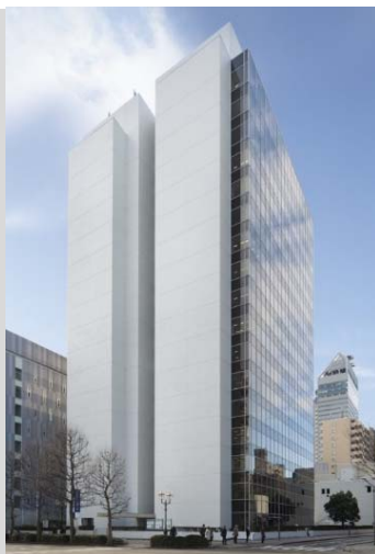
仙台キャピタルタワー
