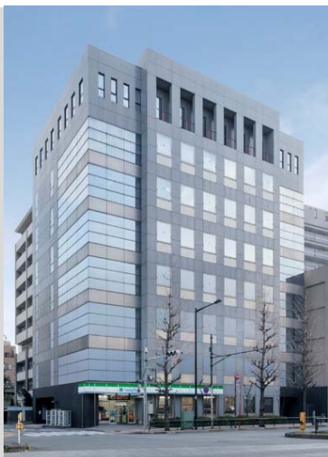
M-City江戸川橋ビル
