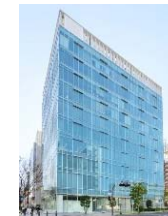
トヨタモビリティサービス本社ビル
