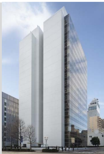
仙台キャピタルタワー
