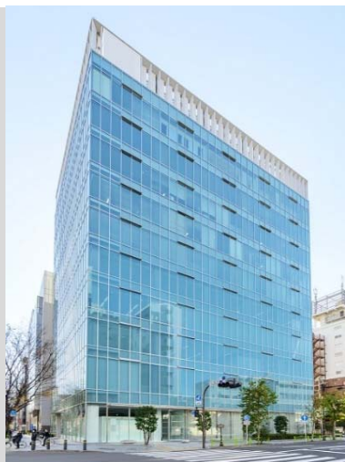
トヨタモビリティサービス本社ビル
