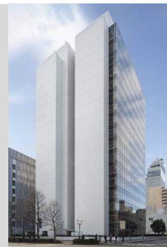
仙台キャピタルタワー
