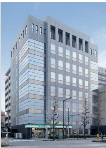
M-City江戸川橋ビル
