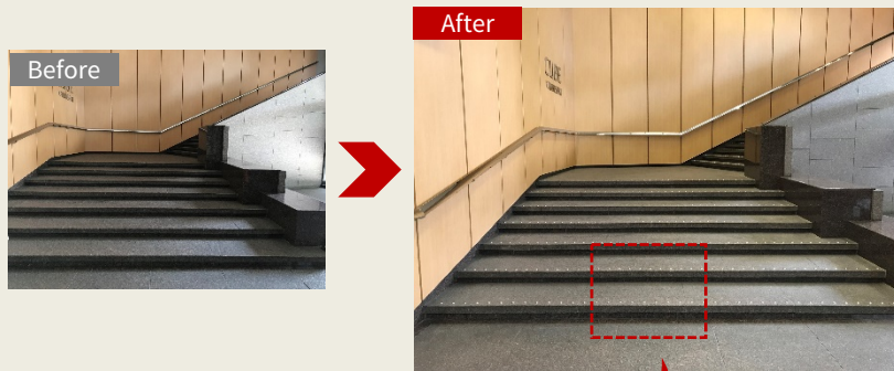
新たに設置した点字鋇 (拡大図)
