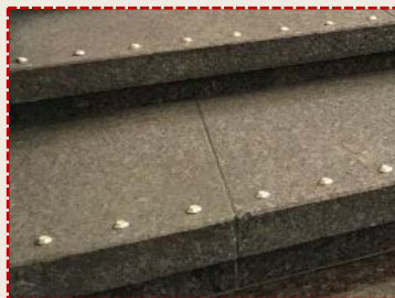
新たに設置した点字鋇 (拡大図)
